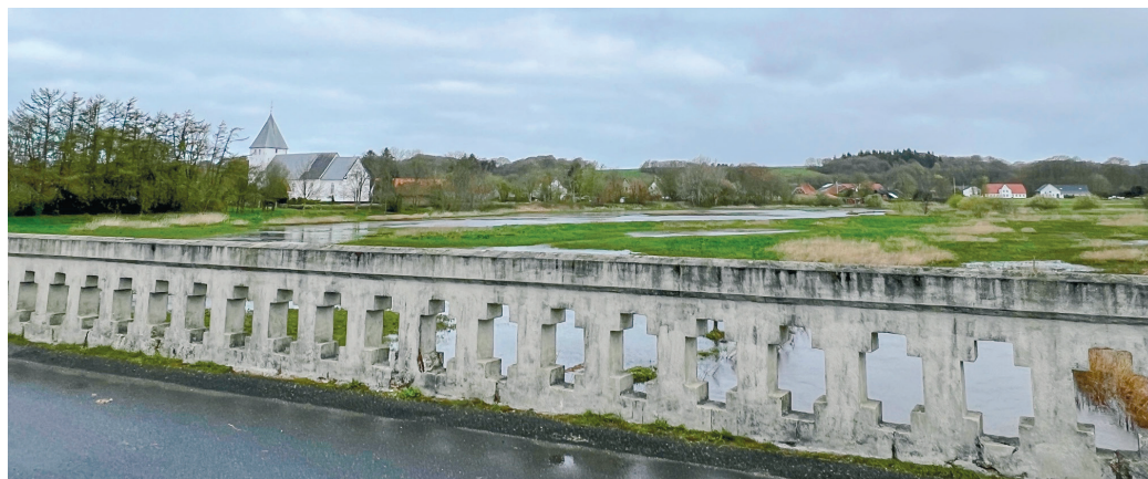
Das charakteristische Betongeländer beim Lobach.
