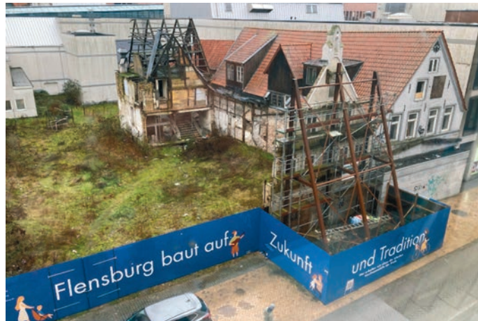
Seit Jahren ein gewohntes Bild: die Sinnerup-Baustelle in Flensburg. OVE JENSEN/SHZ.DE
