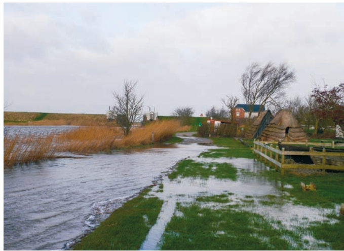
Die bei Hoyer ins Wattenmeer mündende Wiedau weist immer häufiger Hochwasserstände auf: Es gibt als Folge des Klimawandels mit steigenden Temperaturen immer öfter Starkregen – und der immer höhere Meeresspiegel verkürzt die Zeiten, in denen das Binnenwasser durch Schleusen ins Meer abfließen kann.
