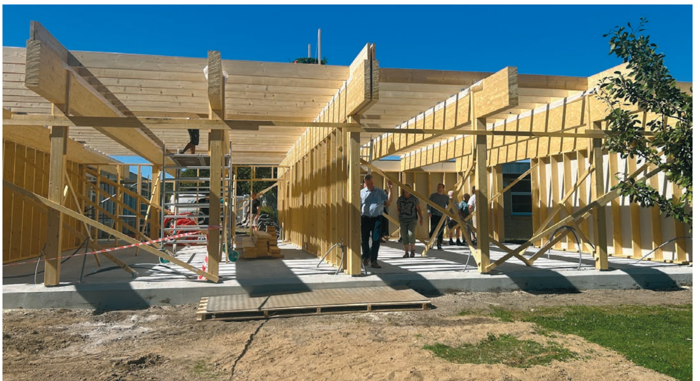
Das Grundgerüst für die zwei neuen Klassenräume steht.
