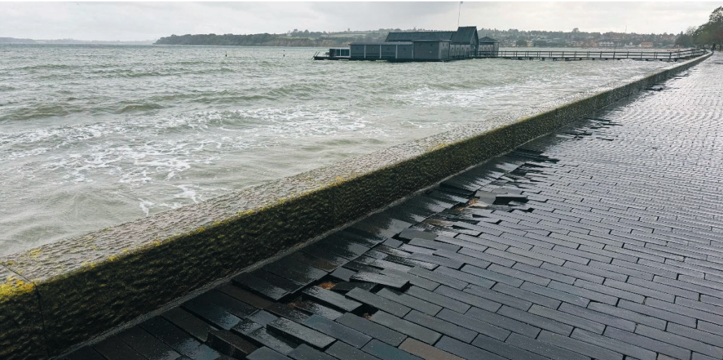
Die Strandpromenade in Sonderburg ist in den vergangenen Jahren durch Hochwasser immer wieder beschädigt worden. Eine dauerhafte und sturmflutsichere Renovierung soll dem vorbeugen.
