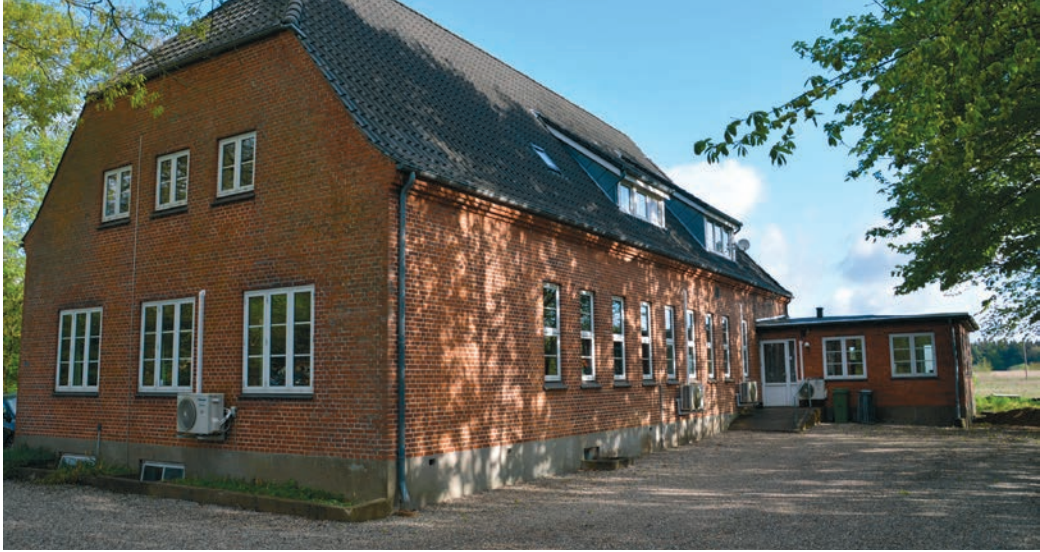
Nach Problemen wegen des vollgelaufenen Kellers ist das Deutsche Haus Jündewatt wieder nutzbar. KJT
