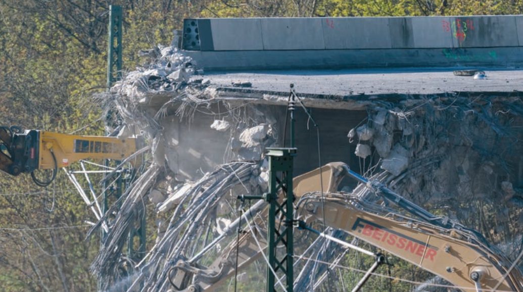
Die Abrisskante der Ringbahnbrücke im Berliner Westen.
