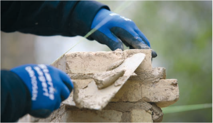
Alte Ziegel und historischer Mörtel sowie das Können des Maurers lassen die Mauer an der alten Kathedralschule wieder auferstehen. HELGE MÖLLER
