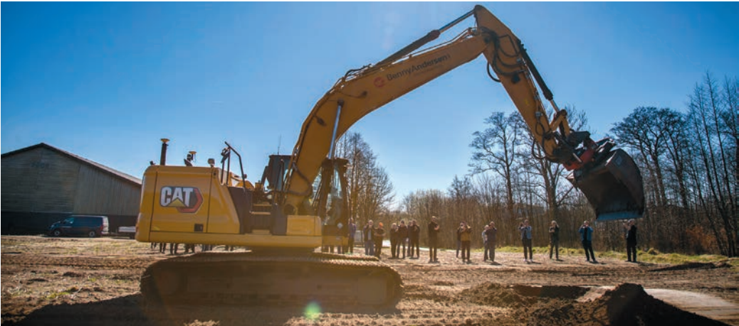
Beim ersten Spatenstich für den neuen Flussverlauf in Jündewatt kam schweres Gerät zum Einsatz. KARIN RIGGELSEN
