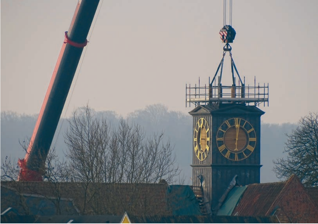
Der Morgennebel hatte sich noch nicht ganz gelegt, als das erste Kirchturmteil hoch über die Dächer der Apenrader Altstadt gehievt wurde. Ein Leser der Zeitung hatte von seiner Terrasse aus diesen tollen Ausblick.
