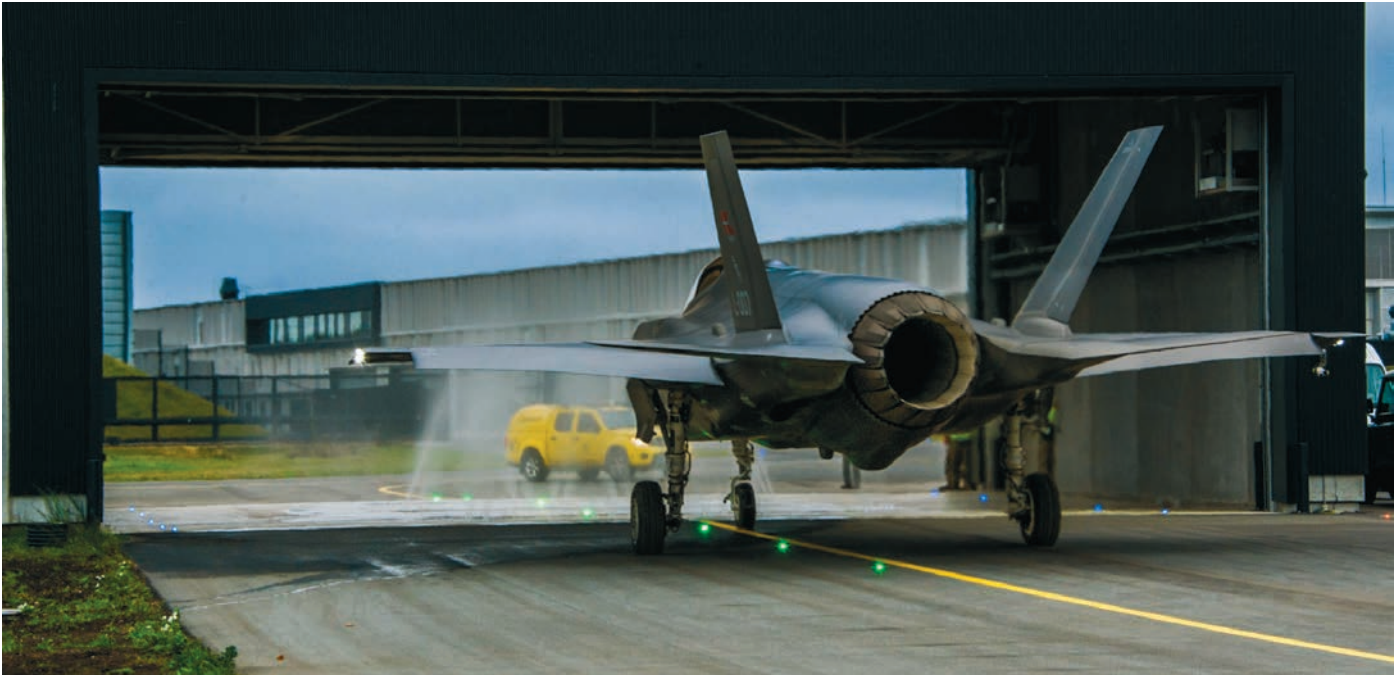
Die Waschstraße für die F-35 ist Teil der hochmodernen Hangaranlage in Skrydstrup. FORSVARETS FOTOTJENESTE
