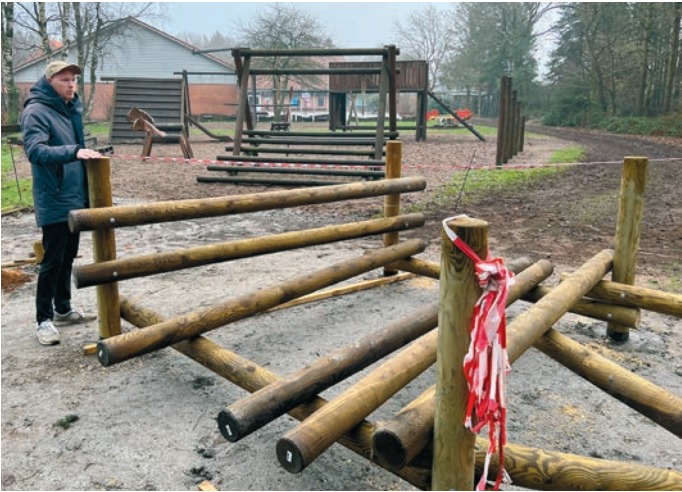
Hans Martin Asmussen am Rohbau der neuen Fitness- und Bewegungsbahn, die dank des SC Saxburg gebaut werden kann.
