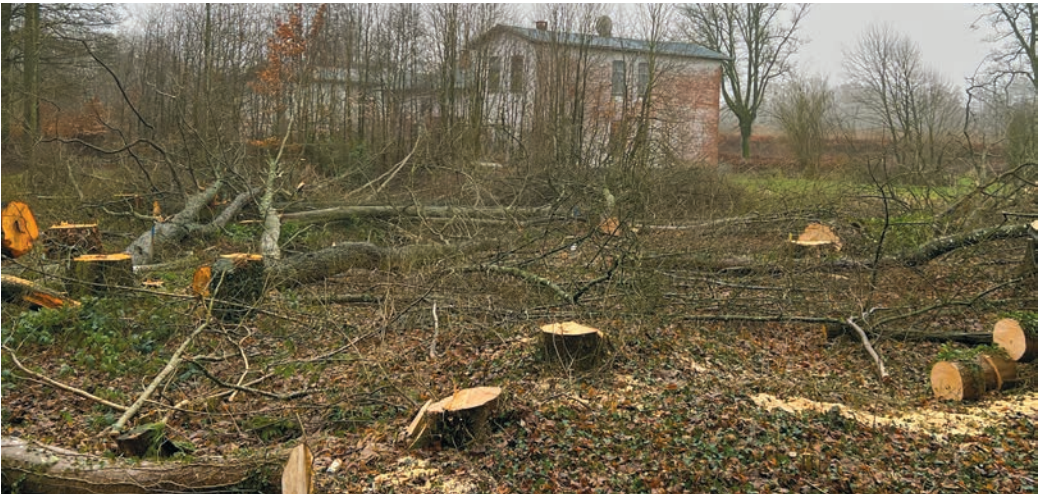
Die Arbeiten haben begonnen: Für den geplanten neuen Flusslauf bei der Jündewatter Wassermühle sind Bäume gefällt worden. KJT
