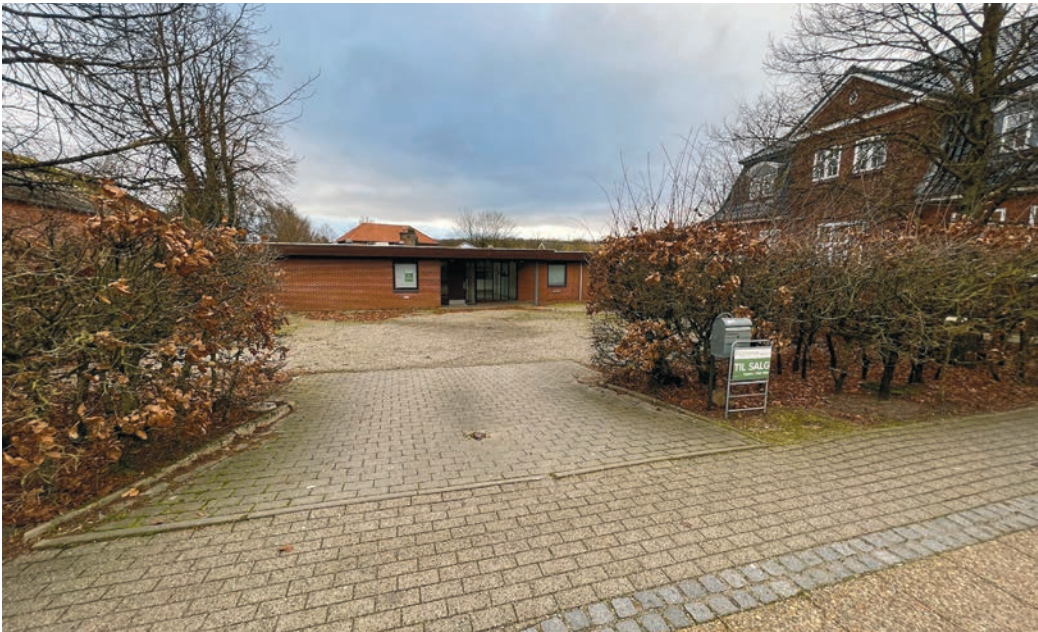
Durch eine Änderung des Flächennutzungsplans könnten im ehemaligen Ärztehaus (r.) und im Erdgeschoss der benachbarten Immobilien bald Wohnungen entstehen.
