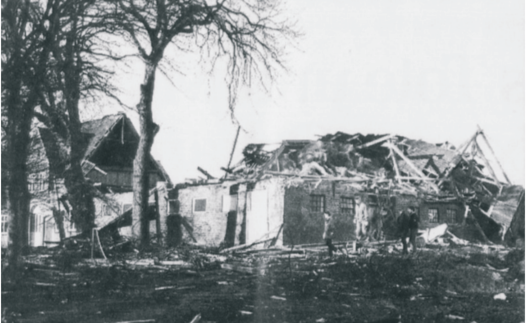
„Der Nordschleswiger“ berichtete in den Tagen danach über die Schäden in Nordschleswig. Auf dem Foto sind die Verwüstungen durch den Dezemberorkan auf einem Bauernhof in Dürhuus bei Tøndern zu sehen.
