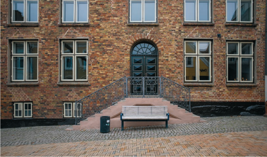
Die Fassade der Orgelmanufaktur zeigt nur einen kleinen Teil des Gebäudes. Dieses erstreckt sich weit nach hinten hinaus.
