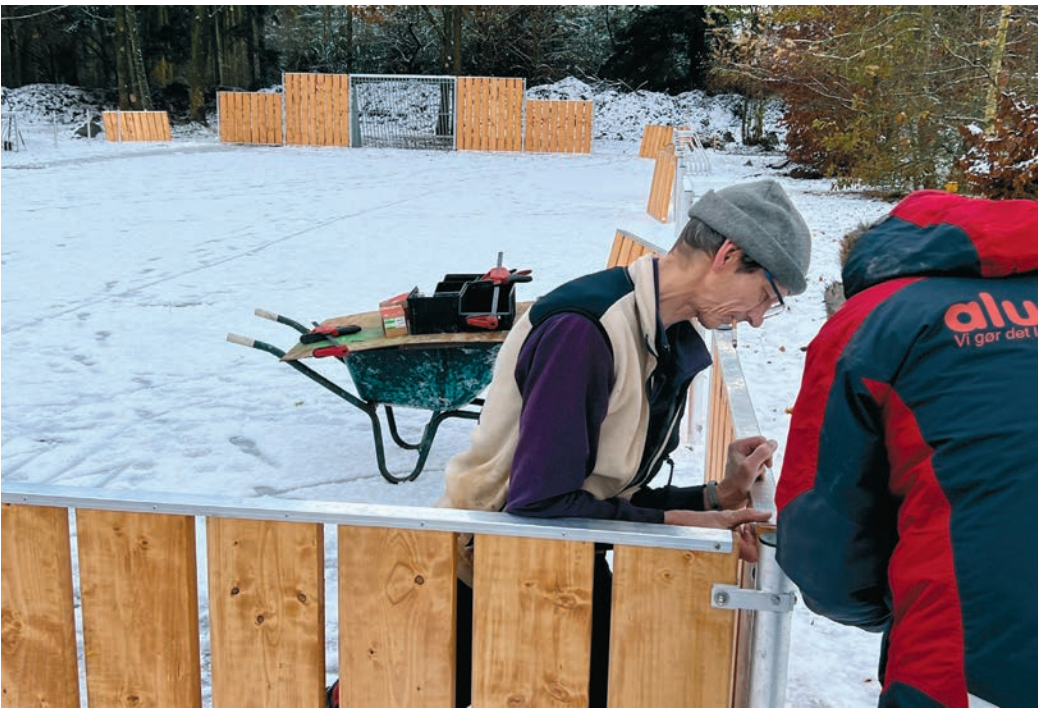
Arbeiter montieren die Banden der Multibahn an der Deutschen Schule Buhrkall. Vom winterlichen Wetter ließen sie sich nicht aufhalten.
