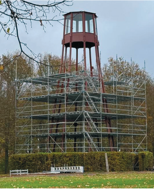
Das Baugerüst ist vor einigen Tagen abgebaut worden und das Glockenspiel-Gerüst präsentiert sich in einem frischen Farbanstrich.
