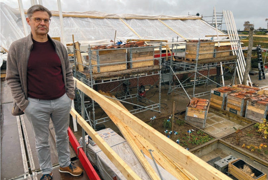
Für Firmendirektor Arne Frederiksen und seine Handwerker ist das Eindecken des Kindergartendachs mit recycelten Ziegeln eine neue Erfahrung. SARA ESKILDSEN
