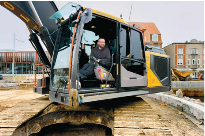
Brian Jørgensen rechnet damit, einen weiteren Monat auf der Riesenbaustelle am Jomfrustien zu verbringen – bis die erste Etappe abgeschlossen ist. UTE LEVISEN
