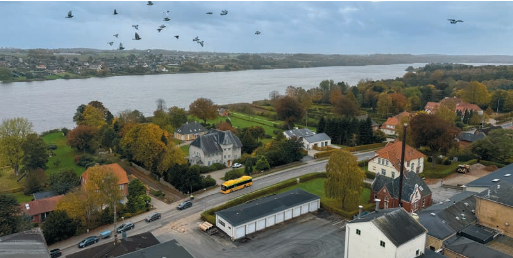
Auf dem Ribe Landevej, in Höhe der Mälzerei Fuglsang, verlegt Provas Abwasserleitungen. Die Strecke muss daher teilweise gesperrt werden. UTE LEVISEN
