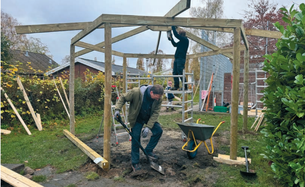
Danny Linke (vorne) und Steffen Schreiber, beim Bau der Grillhütte JAKOB MÜNZ
