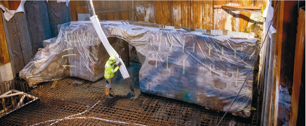
Die Betonarbeiten bestimmen das Bild auf der sonst abgeschirmten Baustelle. TØNDER KOMMUNE
