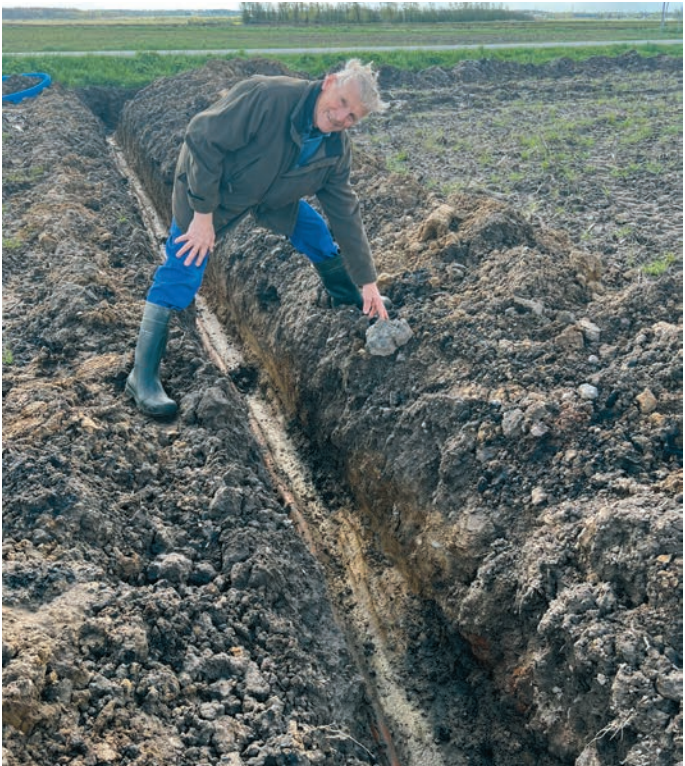
Broder Ratenburg beim Reparieren der Drainage auf dem Feld in Borrig, wo er auf Überreste einer Siedlung aus der Eisenzeit stieß. Um bei der Drainage das richtige Gefälle zu gewährleisten, setzt der erfahrene Landwirt auf Handkraft mit dem Spaten. PRIVAT
