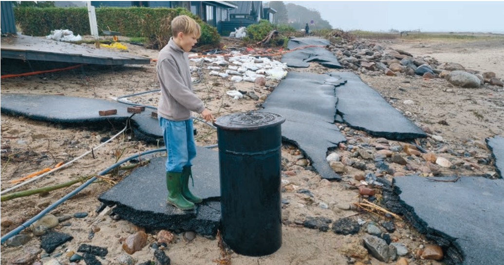
Die Flutschäden an kommunaler Infrastruktur halten sich in Grenzen.
