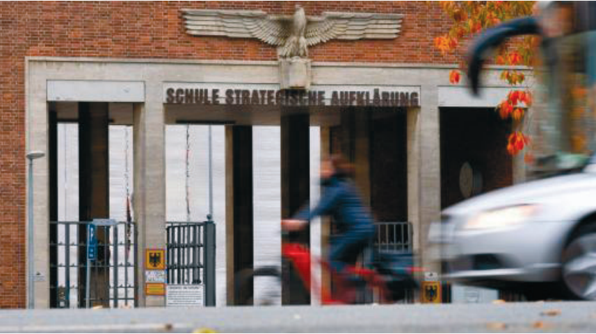
Das Hakenkreuz wurde 1945 entfernt. Der Reichsadler aus der NS-Zeit breitet seine Schwingen weiterhin an der Fassade der früheren Nachrichtenschule aus.
