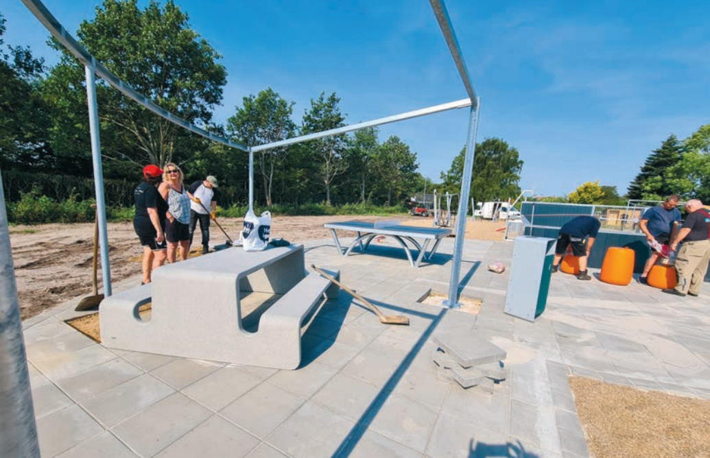
Im Juli packten Freiwillige an, um Fliesen zu verlegen. Die Sitzgelegenheit aus Beton ist für die Jugendlichen gedacht.
