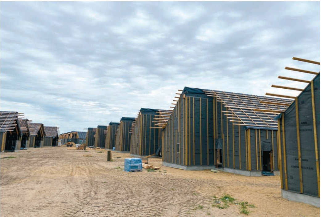
Stand der Bauarbeiten in Kongsmark auf Röm im Juli
