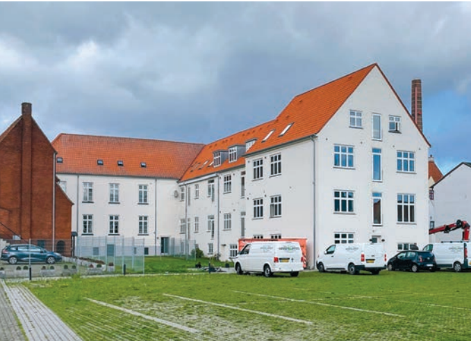
Die Balkone fehlen noch, werden jedoch in den kommenden Wochen montiert.
