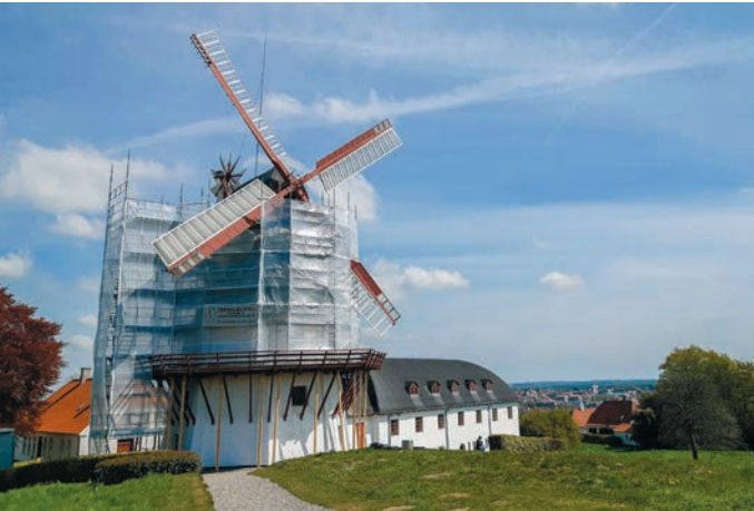
An der Düppeler Mühle wird bis Mitte Juni 2022 gearbeitet. SARA ESKILDSEN
