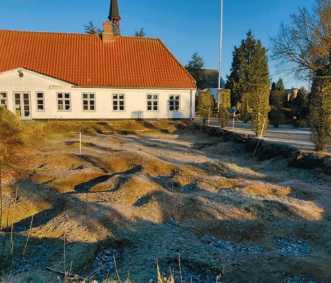
Die alte Schule und die Fläche für den geplanten Anbau
