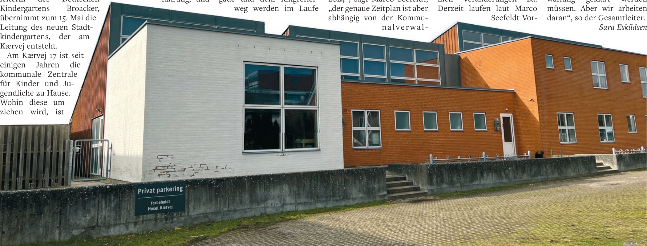
In diesem Gebäude am Kærvej wird der neue Stadtkindergarten einziehen – voraussichtlich im Laufe des Jahres. SARA ESKILDSEN
