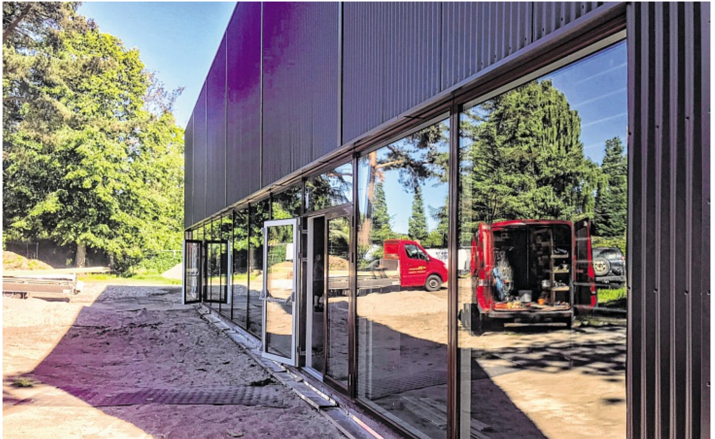
Die neue Turnhalle des Deutschen Gymnasiums für Nordschleswig nimmt Form an.
