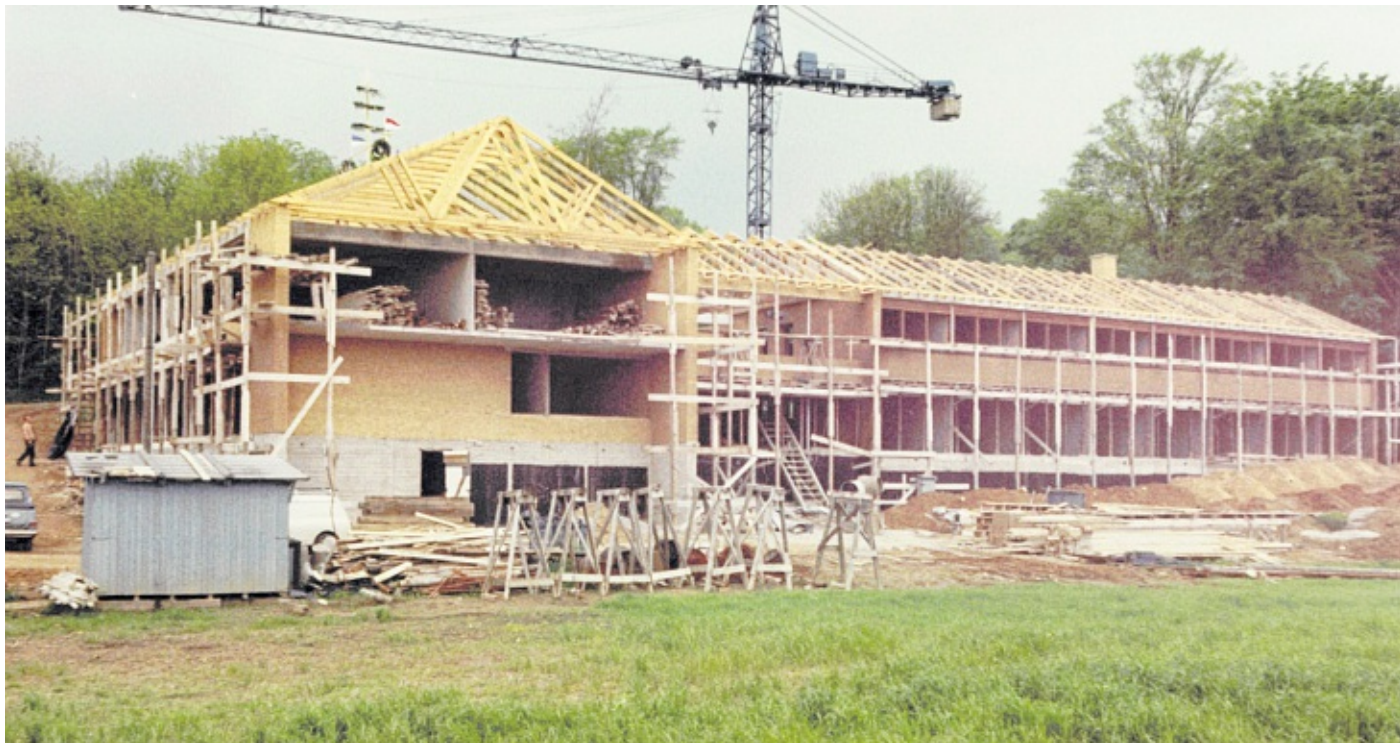
Der Jugendhof in der Bauphase
