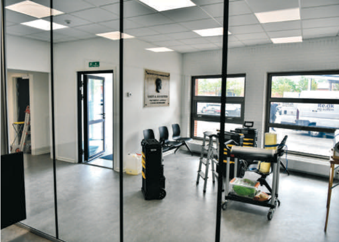
Vom Arbeitsbereich aus können die Polizistinnen und Polizisten sehen, wer im Wartebereich sitzt. Einige Arbeiten werden derzeit noch in der Station ausgeführt.
