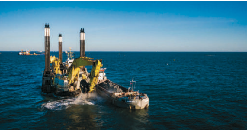
Die Schwimmbagger, die den Graben ausheben, in den die 89 Tunnellemente abgesenkt werden sollen, haben die Hälfte des auszuhebenden Volumens geschafft. O. MALZAHN, FEMERN A/S
