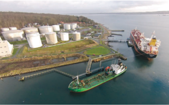
Auf der Ostseite des Südhafens befinden sich große Lager-silos. Hier sollen weitere Lagerkapazitäten entstehen.
