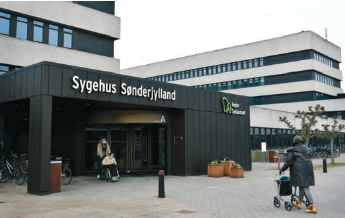
Das Sonderburger Krankenhaus wird auf nachhaltige Energieversorgung umgestellt. Dazu tragen zwei große Danfoss-Wärmepumpen bei. JV.DK / BIRTE JUUL MATHIASSEN
