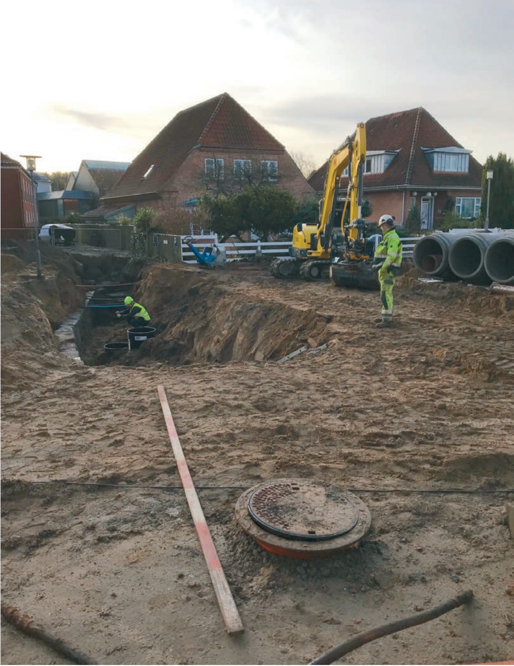
Um die 20 Meter der Hafenmauer sind freigelegt worden. Die maschinellen Arbeiten ruhen im Umfeld der Fundstellen.
