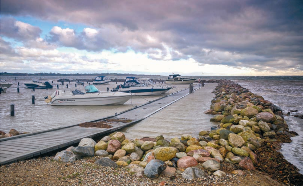
Der Jollenhafen beim Hochwasser im November 2022
