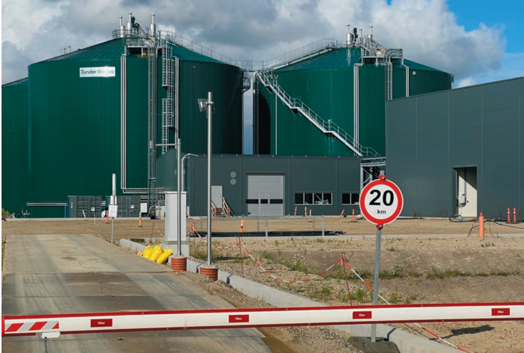
Die Biogasanlage in Sollwig befindet sich im Bau.
