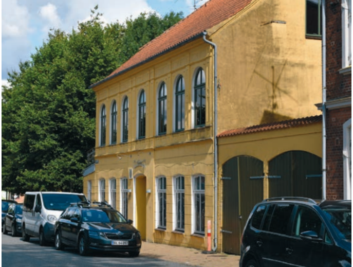
Das Haus Richtsensgade 27 hat bessere Tage gesehen.
