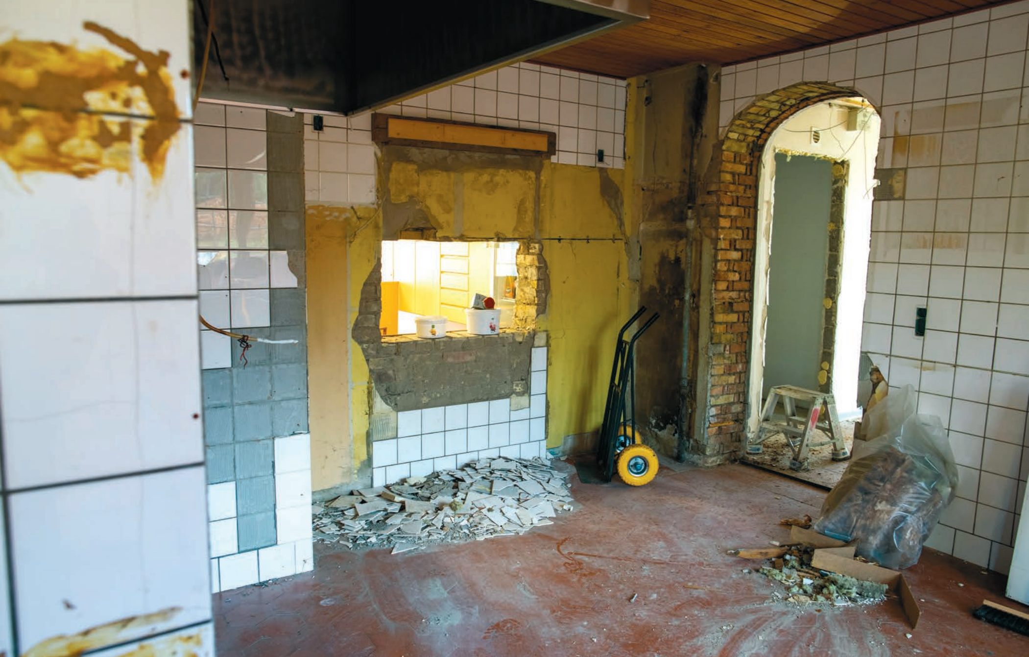
Eine Wand wird ganz entfernt, eine Trennwand eingerissen. Dadurch wächst die Quadratmeterzahl der Küche von derzeit 25 auf 35 an. KARIN RIGGELSEN
