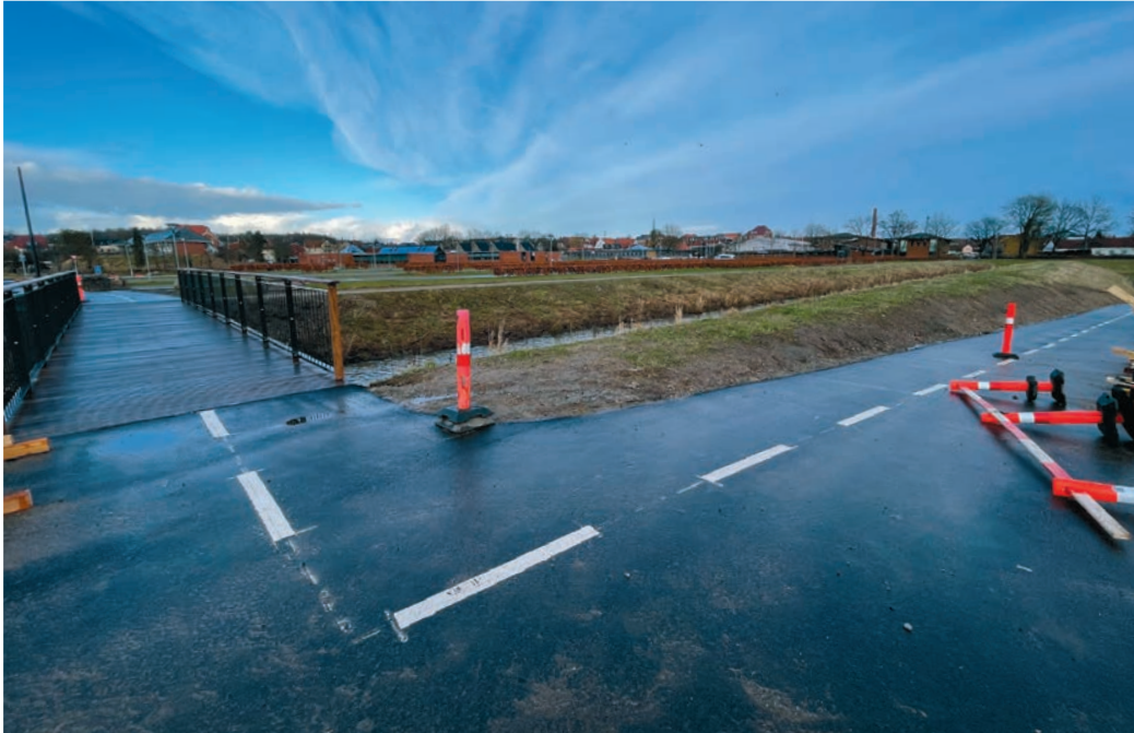
Die neue Brücke vom Norden gesehen.
