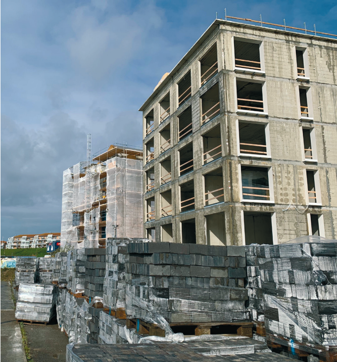
Blick Richtung Norden
