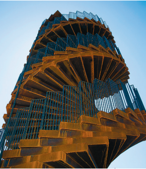
Der Turm während des Bau- prozesses im Juni, als er in halber Höhe nach oben strebte. FOTO: JANE R. OHLSEN
