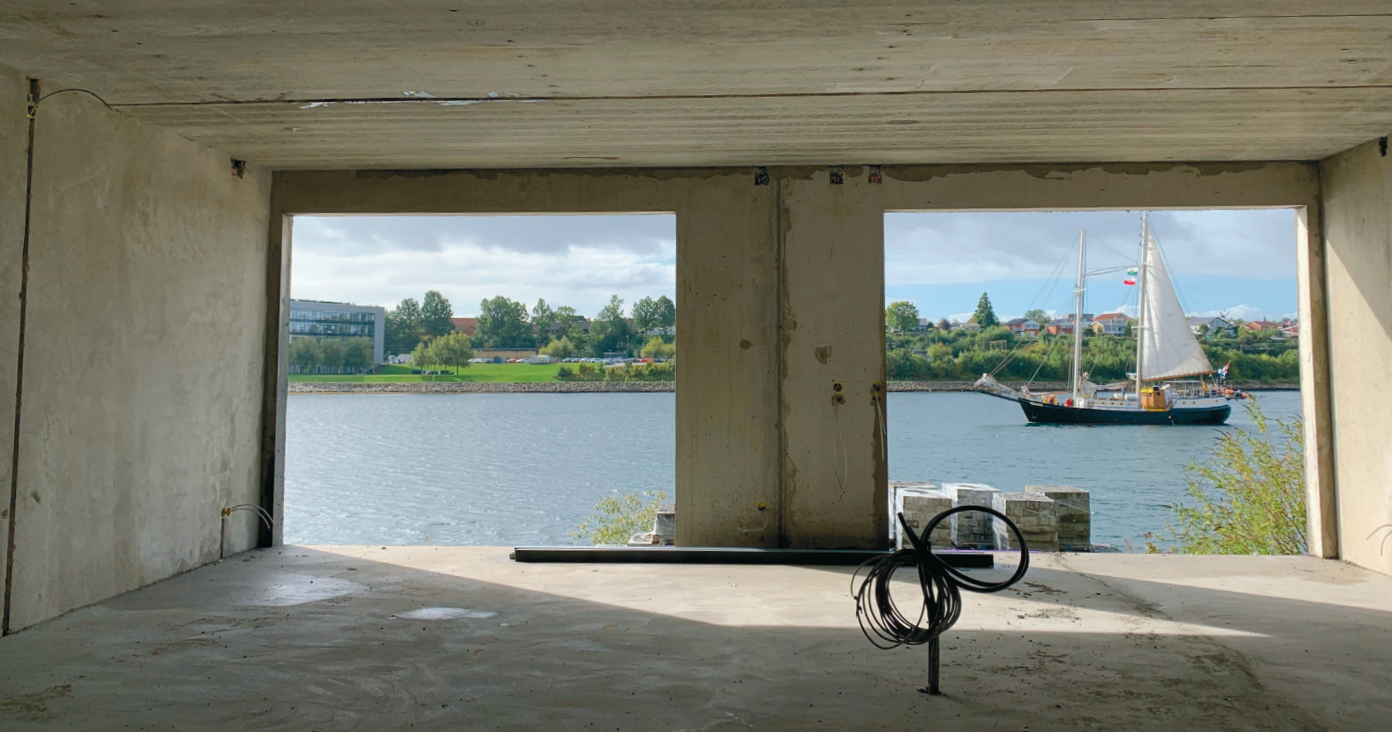
Blick aus dem Rohbau im südlichen Haus
