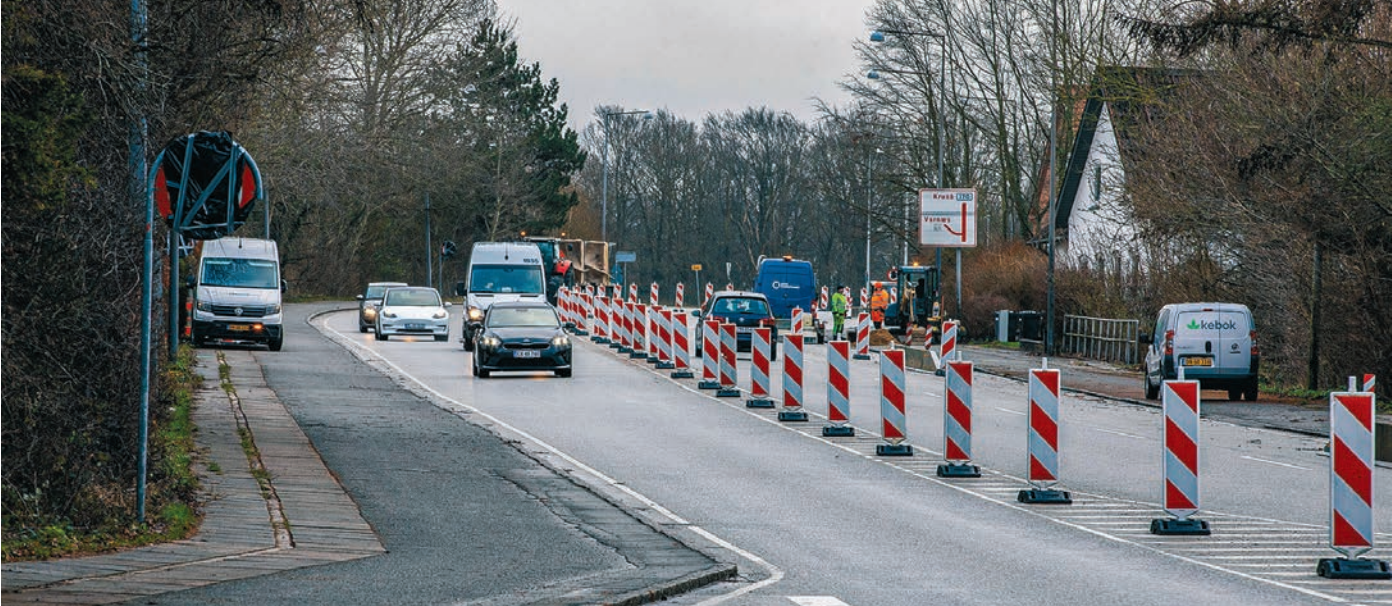
Der Verkehr auf dem Flensborgvej in Richtung Stubbek (Stubæk) wird durch Baken geführt. KARIN RIGGELSEN
