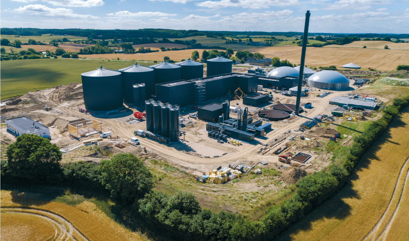
Die Biogasanlage von Nature Energy in Quars
