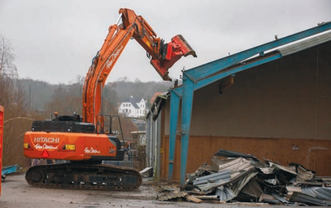
Bagger haben am Dienstagmorgen begonnen, die alte Lagerhalle abzureißen. KARIN RIGGELSEN
