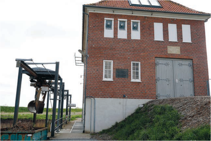
Das Schöpfwerk in Legan ist das größte von vieren in der Tonderner Marsch. Es wurde vom früheren Gutsverwalter von Schackenborg, H. C. Davidsen (1876-1962), und dem Architekten Nic. Andersen (1882-1949) gezeichnet.
