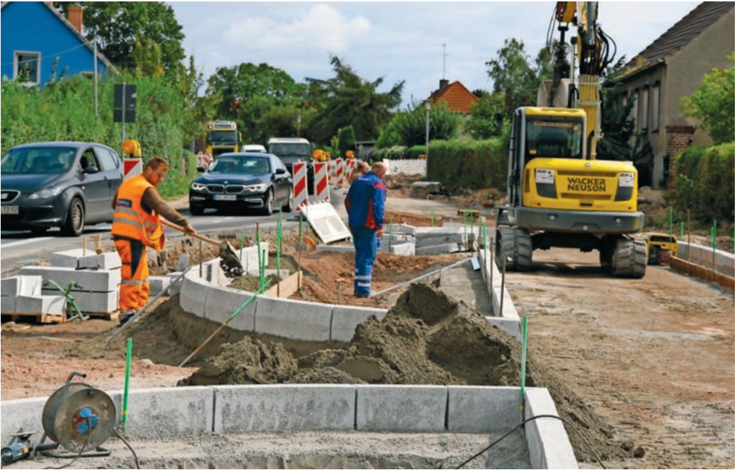
Der Ausbau der Bundesstraße läuft.
