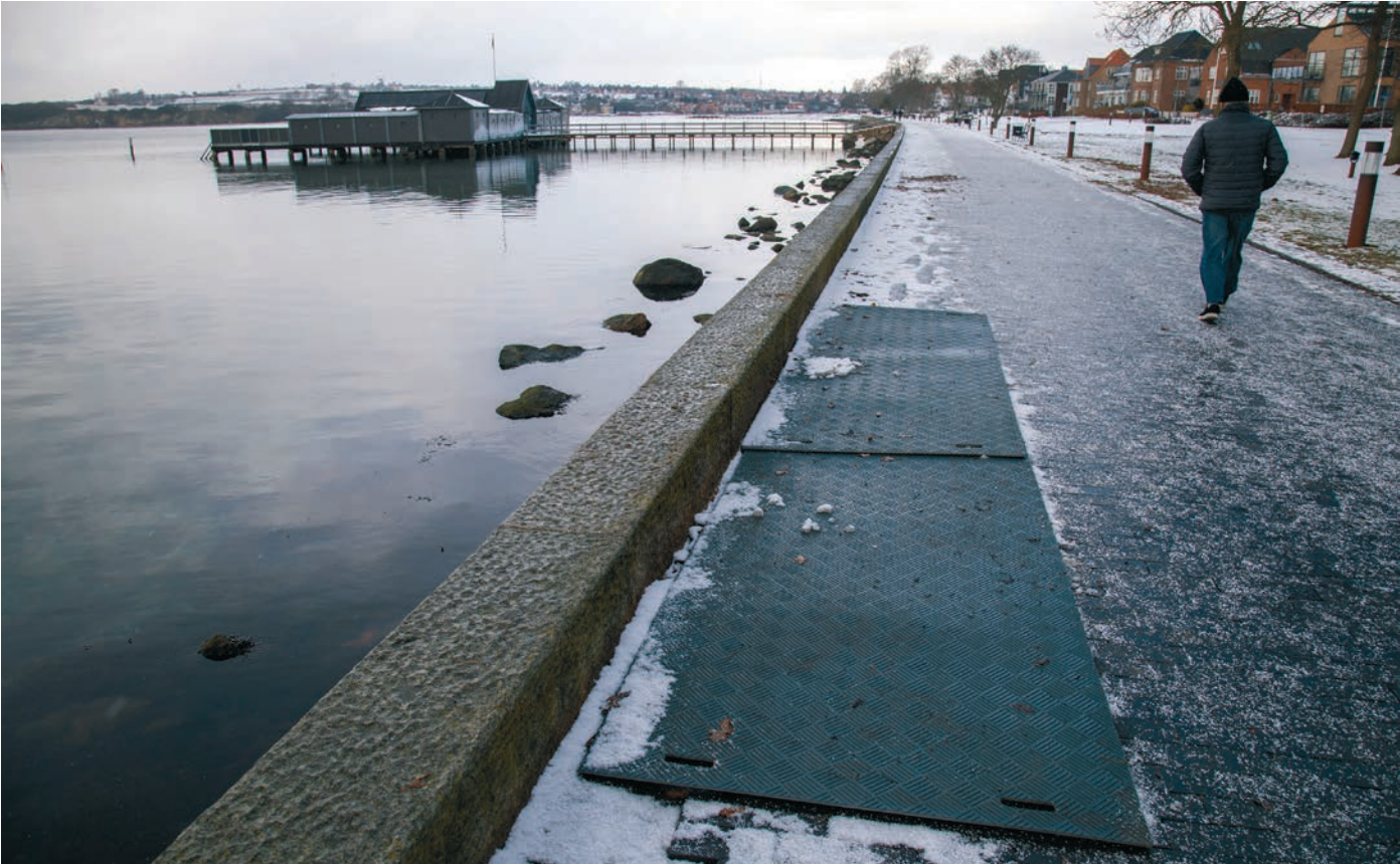
An vier Stellen wurden die Fliesen angehoben.
