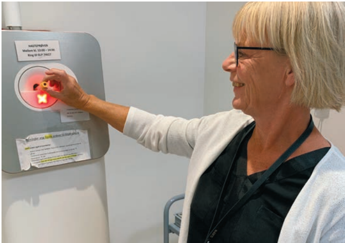
Laufwege in den Keller fallen weg: Susan Cording zeigt, wie eine Blutprobe ins Labor geschickt wird.
