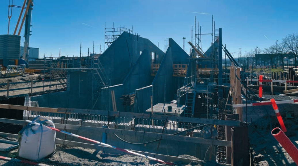
Die Pumpen-Schleusen-Station ist im Bau. Die spätere Form der Aussichtsplattform ist schon gut zu erkennen. JAN PETERS
