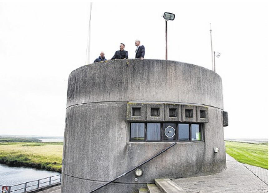
Der Turm der Wiedausschleuse erhält zwei neue Etagen mit einer Aussichtsplattform.
