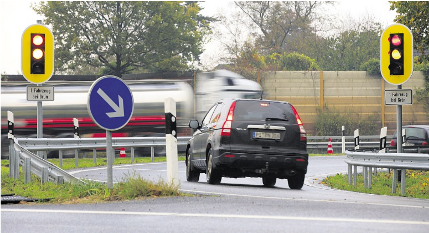
Jeder für sich: Bei starkem Verkehr dürfen die Fahrzeuge nur noch einzeln auf die Autobahn auffahren.
