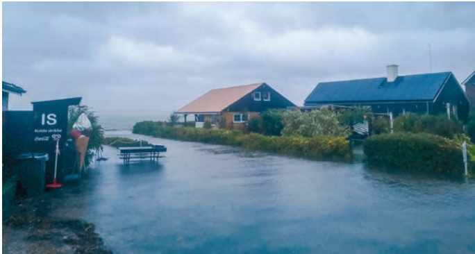
Die Überschwemmungen der Sturmflut trafen das Haus der Familie schwer.
