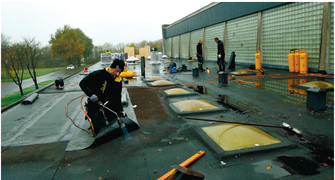
Das Vorhallendach der Tingleffer Sporthalle wird erneuert. FRIEDRICH HARTUNG
