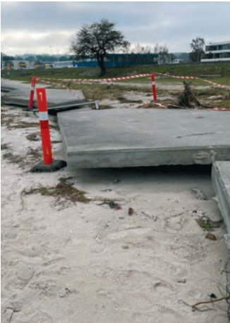
Eine der Gehwegplatten am Apenrader Sønderstrand wiegt etwa zehn Tonnen. Die Kraft der Fluten hat die Platte verschoben.
