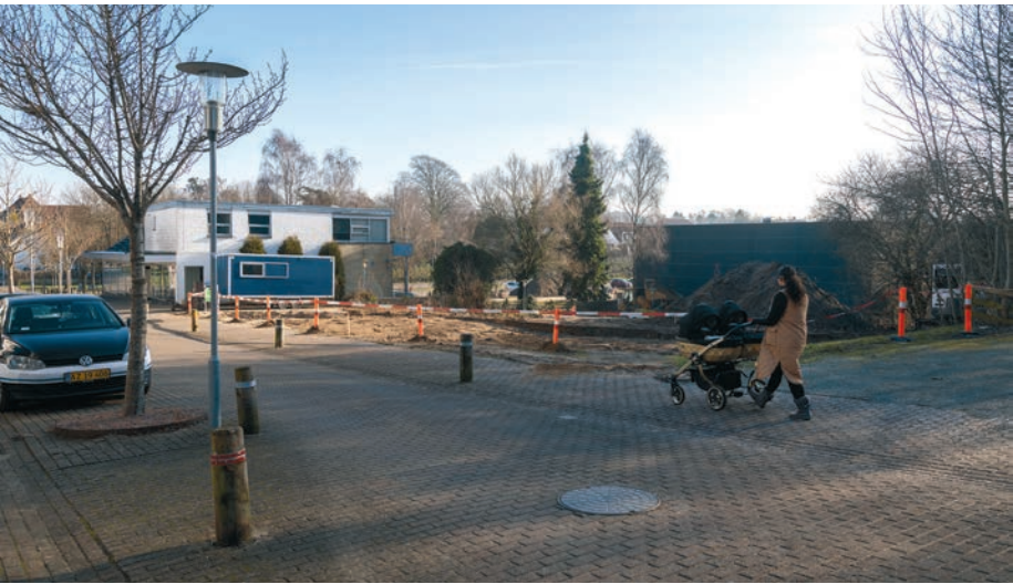
So sieht das Gelände des neuen Stadtparks heute aus.
