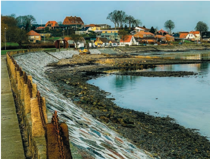
Die Steine der Küste werden gesichert.
