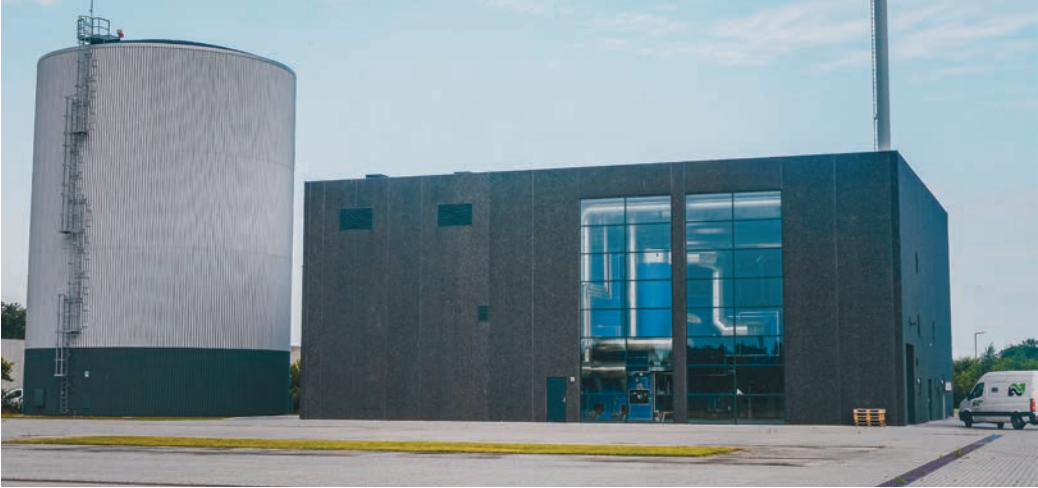
In Tondern ist die Fernwärmegesellschaft bereit, weitere Haushalte an das Fernwärmenetz anzuschließen, die bisher auf Erdgas als Energiequelle zurückgreifen. Bis 2030 soll in Dänemark das Beheizen der Wohnräume mit Gas oder Öl beendet werden, als Beitrag zum Klimaschutz.
