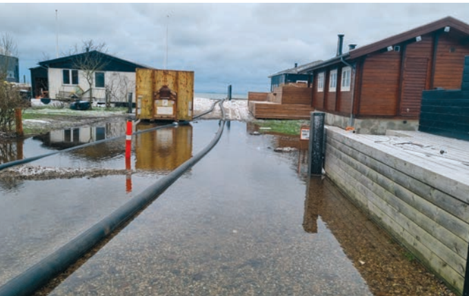
Am Kjelstruper Strand waren erneut die Pumpen im Einsatz. So sah es am Donnerstagvormittag vor Ort aus.
