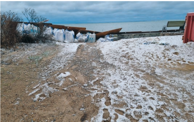
Sandsäcke und Stahlplatten in Kjelstrup sollten gegen das eindringende Wasser schützen.
