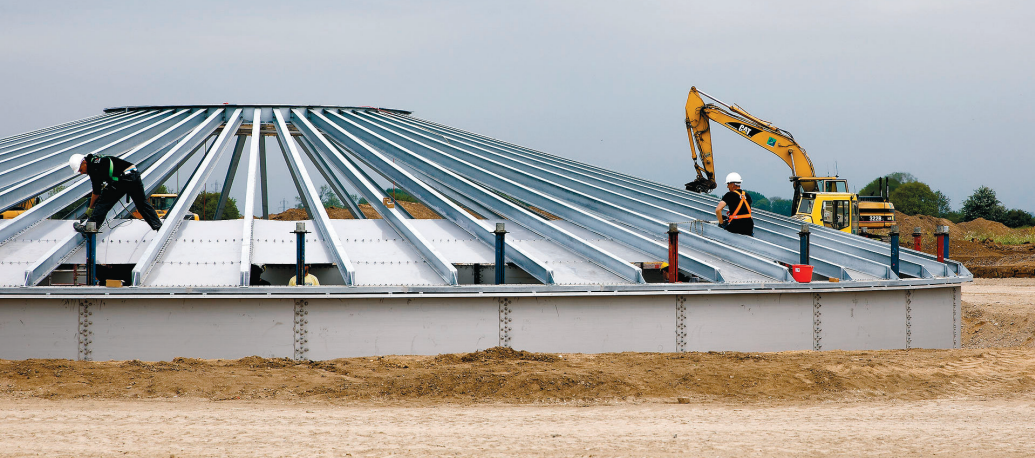
Hier ist der Bau der Biogasanlage in Glansager zu sehen.
