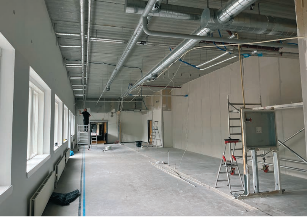
In den vergangenen Monaten wurde ein Teil des alten Krankenhauses renoviert.
