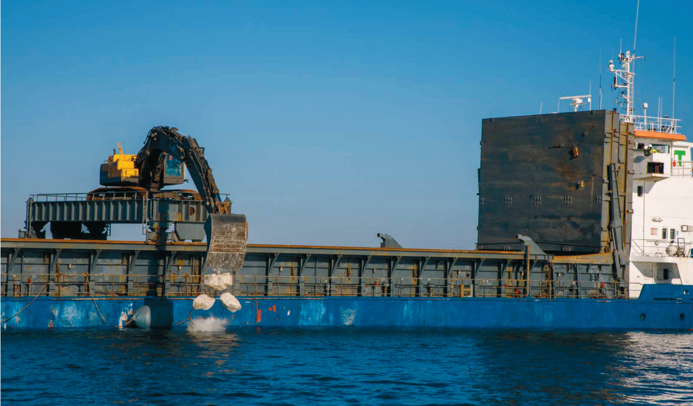
Die Steine werden in großen Schiffen zu der Platzierung der neuen Steinriffe gebracht.
