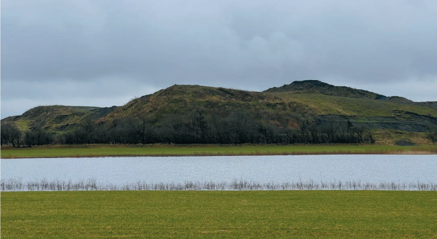
Der „Berg“ der Erddeponie bei Uk. An den Seiten sind kleine Abbrüche erkennbar.
