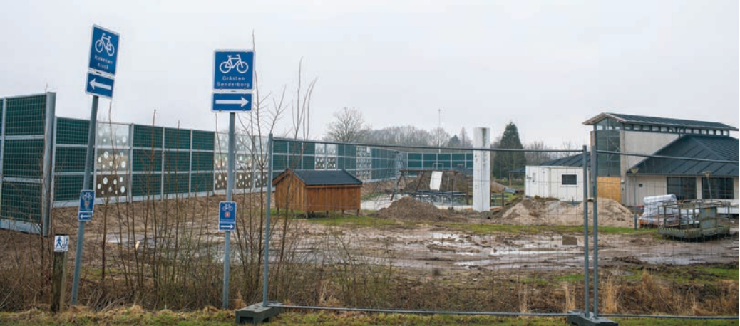
Die Mauer schirmt das Kindergartengelände zum Egersund Brovej hin ab.
