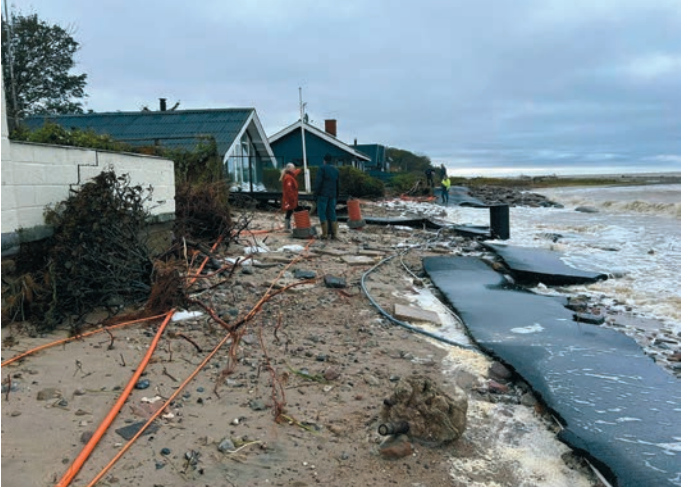
Die Zerstörungen am Wilstrup Strand KOMMUNE HADERSLEBEN
