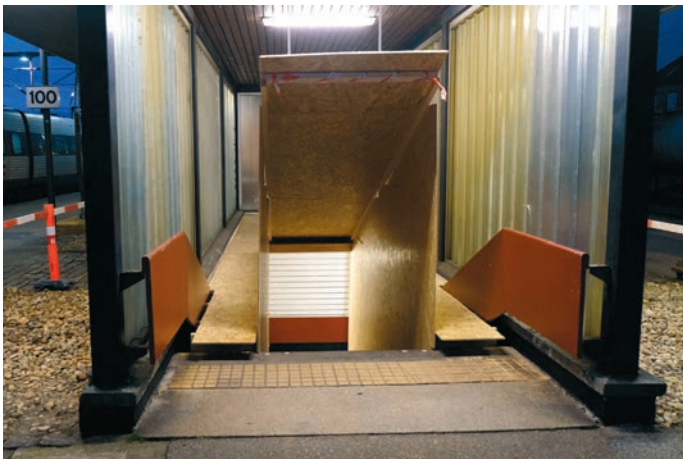
Der Treppenaufgang am Pattburger Bahnhof ist mit Holz verändert worden.
