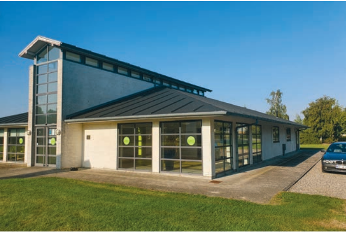
In diesem Gebäude soll ab 2024 der Deutsche Kindergarten Gravenstein untergebracht werden. DSSV
