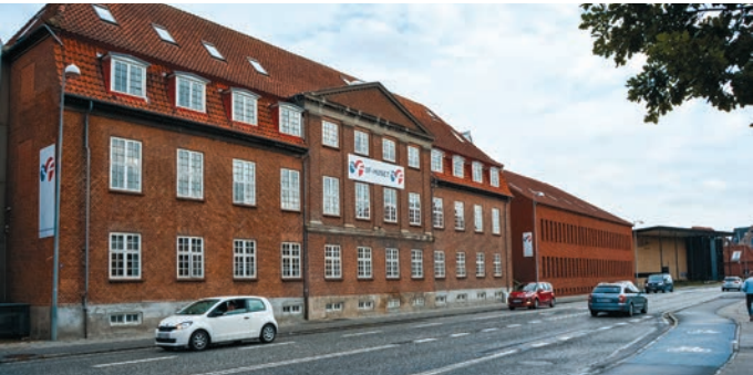
In dieses Gebäude wird die Polizeistation ziehen.FOTO: PETERS
