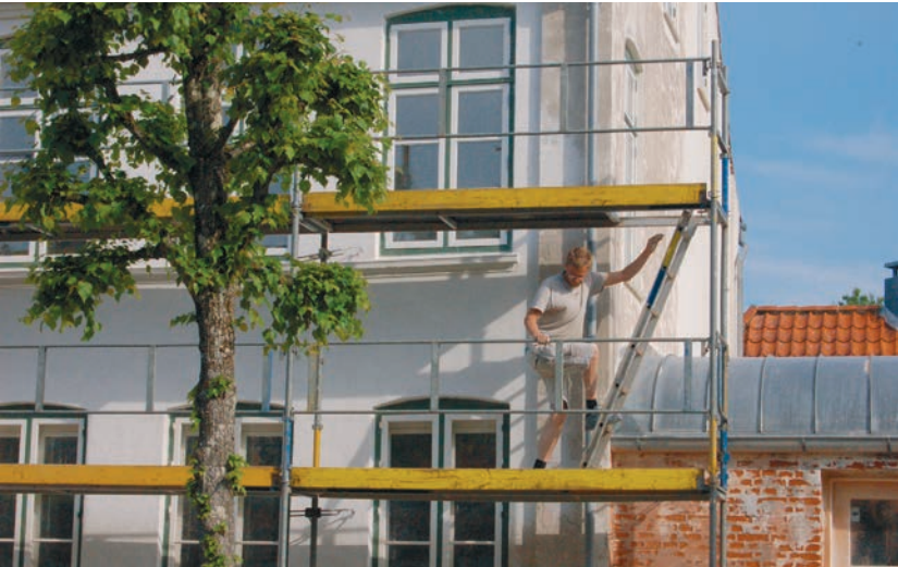
Der Schlosskrug wurde neu verputzt.
